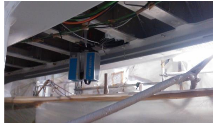
Scanning im Überkopfbetrieb an einer Yacht
