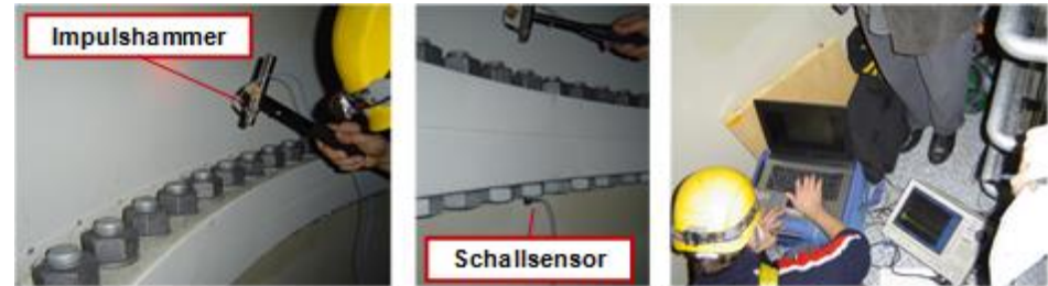
Messaufbau zur Bestimmung von Schraubenvorspannkraften einer Flanschverbindung in einer Windenergieanlage
