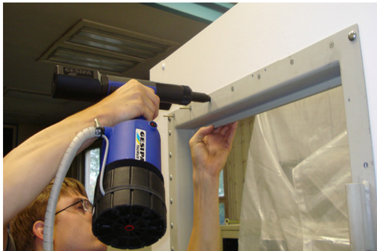
Alternative Montage von Türzargen durch Blindnieten nach der Endkonservierung ohne Nacharbeiten durch Schweißen
