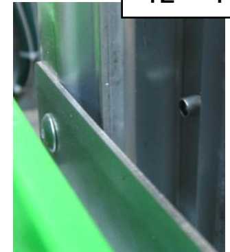
Schwingend beanspruchte Blindnietverbindungen in Hochregallagern [Quelle: Fa. FAS Förderanlagen Systeme GmbH]
